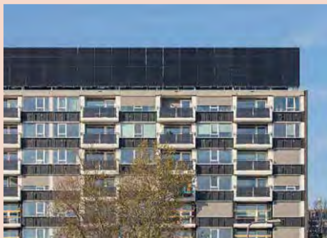
Zonnepanelen op het dak in de vorm van een 'kroon'.
