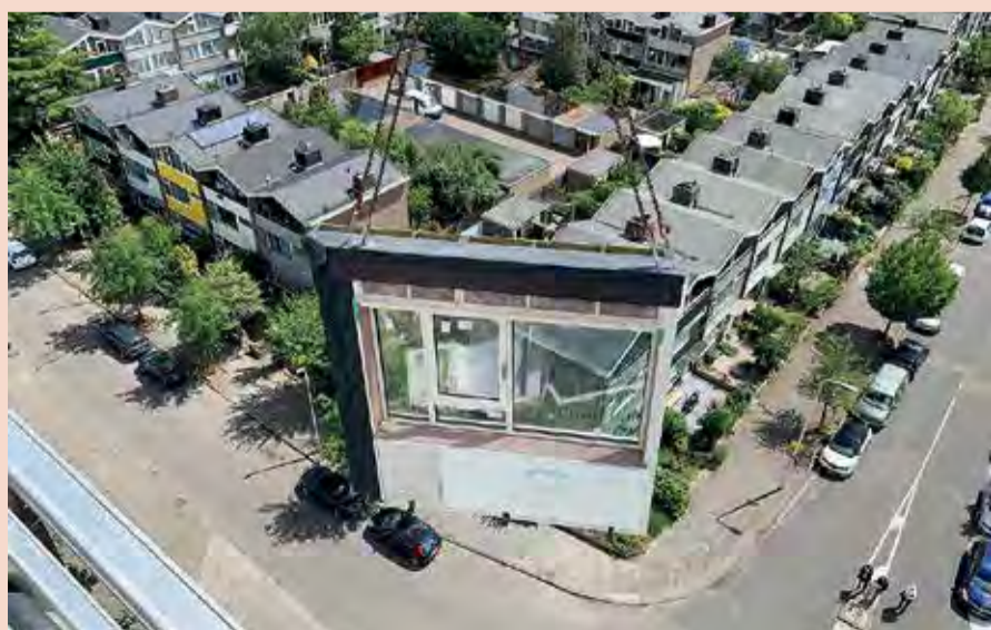
Prefab-gevels met de ClimaRad ventilatie-oplossing zijn 1 voor 1 naar boven gehesen.
